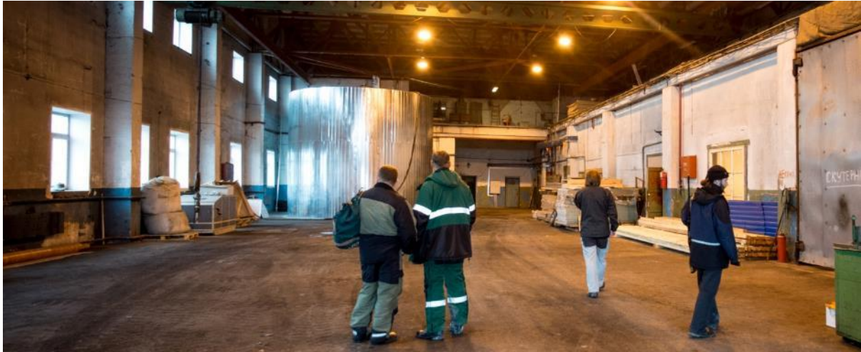
Garasje med vanntank
