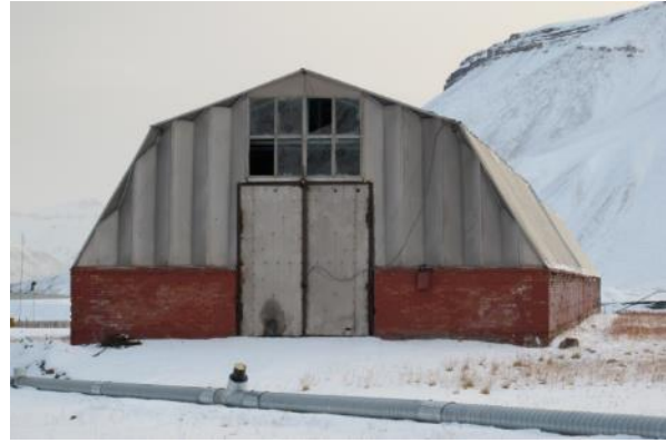
Nytt system med isolerte rør på bakken.
