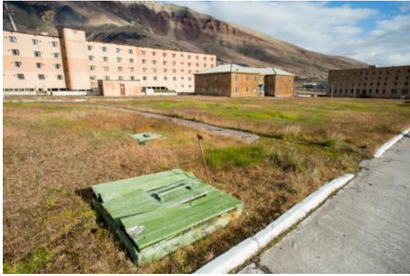
Inspeksjonsluke opprinnelig avløpssystem.
