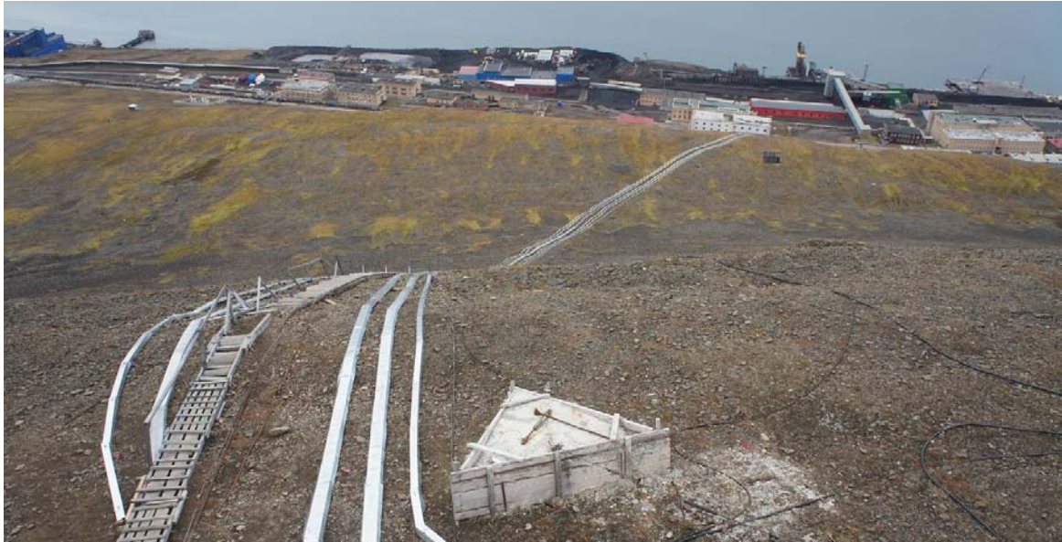
Gangbane og kabeltrasé fra byen
