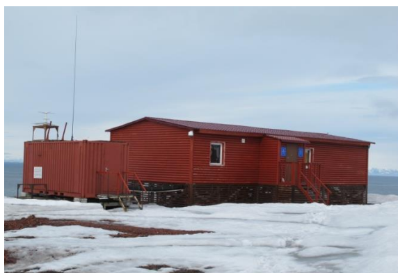
Arbeidspaviljong og en driftsteknisk konteiner
