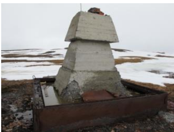
Gamle betongfundament med ukjent opprinnelse. Trolig ikke eldre enn 1946
